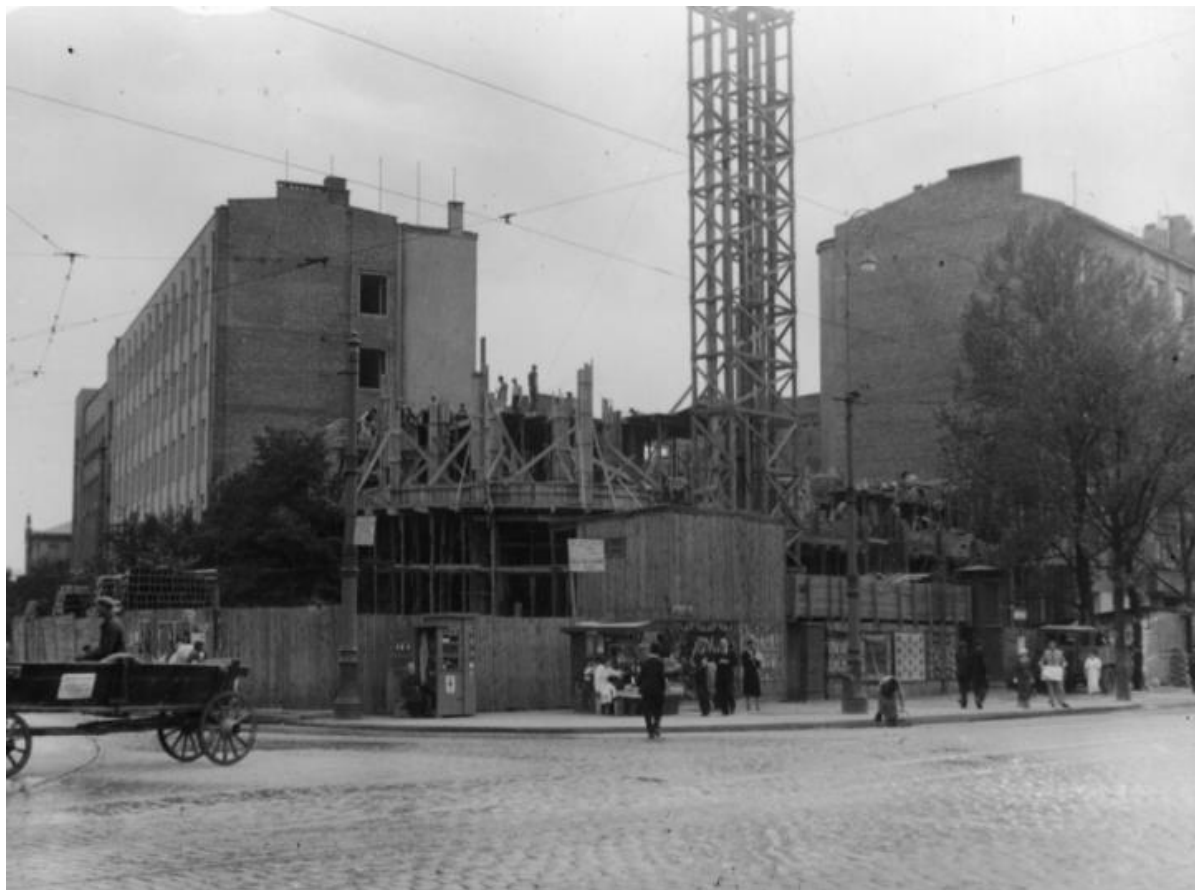
Ryc. 2. Dom Turystyczny w czasie budowy, 1938 r. Widoczne kioski handlowe, przechodnie i furmanka. Po lewej stronie pierwsze ukończone skrzydło domu.
