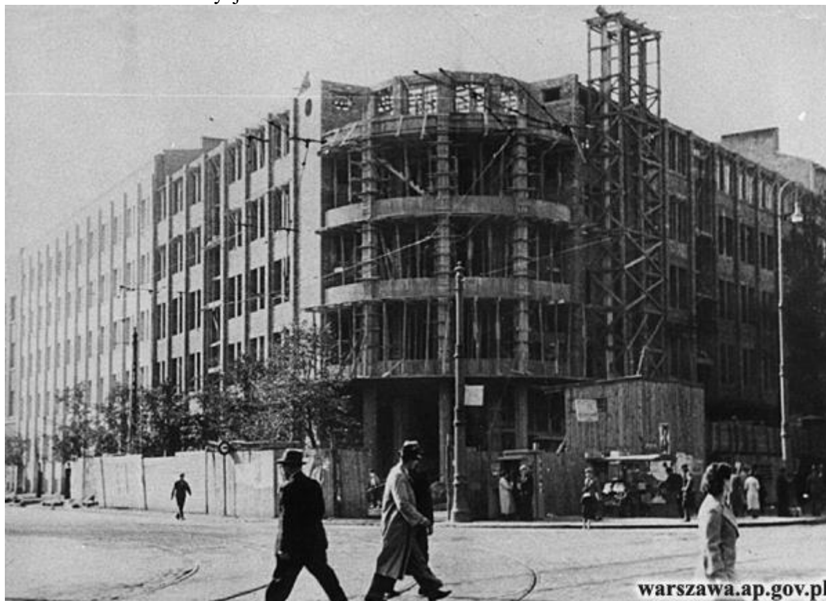
Ryc. 3. Dom Turystyczny w Warszawie podczas budowy części frontowej, przełom 1938 i 1939 r.
